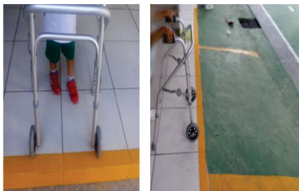
Fotos 6/7 – Degrau/rampa de acesso ao parque
